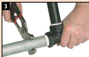
3. No lo apriete demasiado. La manera correcta de ensamblar una conexión de tubo roscado es apretándola con los dedos mas otras dos vueltas, nada mas.
