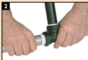
2. Enrosque la tubería en el accesorio
